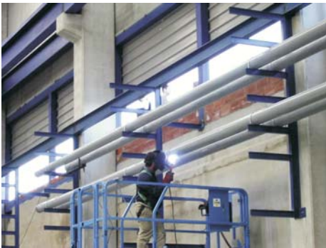
Piping rack for cold water, raw material, and others / Rack de tuberías para circuito de frío, transporte de granza y otros
