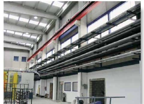
Piping rack for cold water, raw material, and others / Rack de tuberías para circuito de frío, transporte de granza y otros
