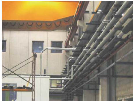
Piping rack for cold water, raw material, and others / Rack de tuberías para circuito de frío, transporte de granza y otros
