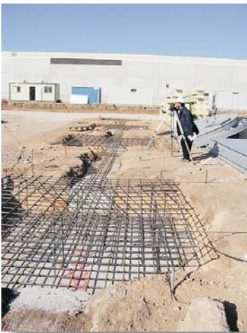
Storage and packing warehouse / Nave de almacén y Paletizado
