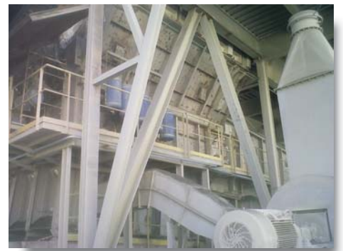
Structure strengthening before the erection of the new head / Refuerzo de estructuras existentes antes del montaje del Nuevo cabezal
