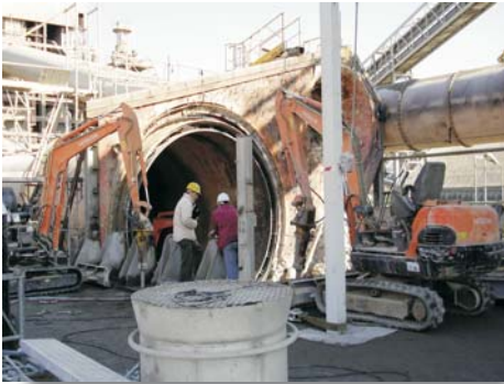
Erection of the new head: panels and new arched roof / Montaje in situ del nuevo cabezal: paneles y cubierta abovedada
