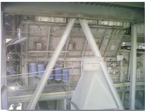
Structure strengthening before the erection of the new head / Refuerzo de estructuras existentes antes del montaje del Nuevo cabezal
