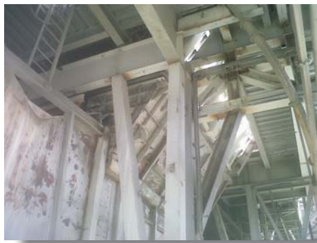
Structure strengthening before the erection of the new head / Refuerzo de estructuras existentes antes del montaje del Nuevo cabezal
