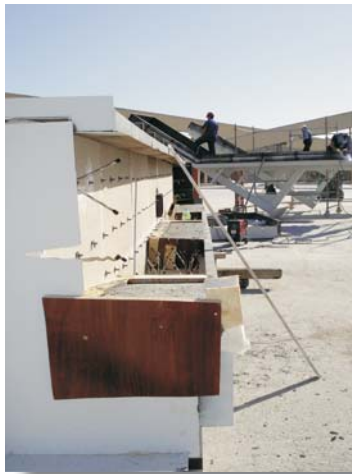
Supply of panels composing the new head for concrete isolation / Suministro del cabezal por módulos a fábrica para su hormigonado refractario
