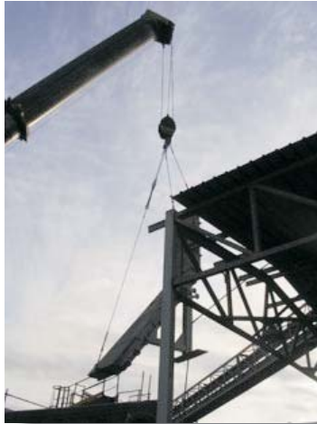
Erection of the new head: panels and new arched roof / Montaje in situ del nuevo cabezal: paneles y cubierta abovedada
