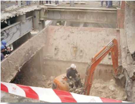
Destruction of the existing head / Demolición y desguace del cabezal existente
