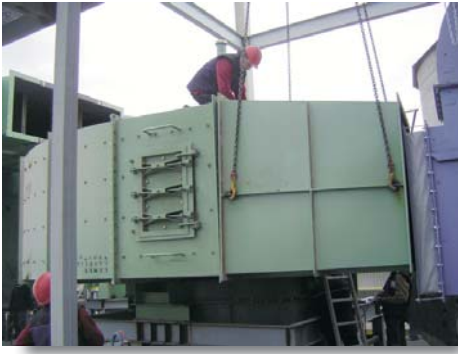
Erection of the cage wheel unit, the outlet head and the air inlet spiral / Montaje de la voluta, rotor y cabezal del separador
