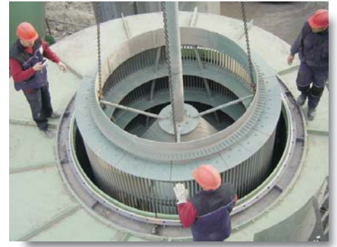
Erection of the cage wheel unit, the outlet head and the air inlet spiral / Montaje de la voluta, rotor y cabezal del separador
