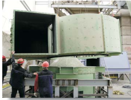
Erection of the cage wheel unit, the outlet head and the air inlet spiral / Montaje de la voluta, rotor y cabezal del separador
