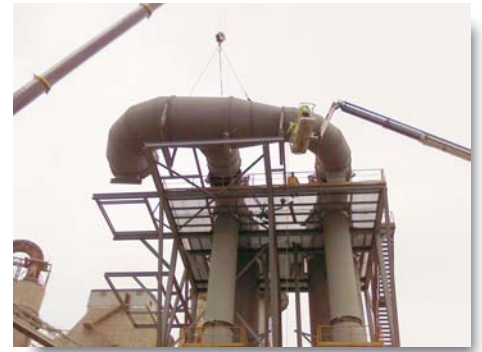
Piping erection. Joint expansion, fixed and mobile support / Montaje de tuberías. Juntas de dilatación, apoyos fijos y deslizantes.
