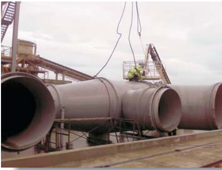
Piping erection. Joint expansion, fixed and mobile support / Montaje de tuberías. Juntas de dilatación, apoyos fijos y deslizantes.
