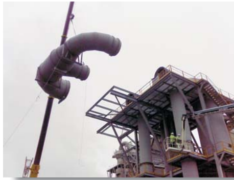
Piping erection. Joint expansion, fixed and mobile support / Montaje de tuberías. Juntas de dilatación, apoyos fijos y deslizantes.
